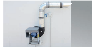
Ex-geschützter Abluftventilator inkl. Abluftüberwachung
