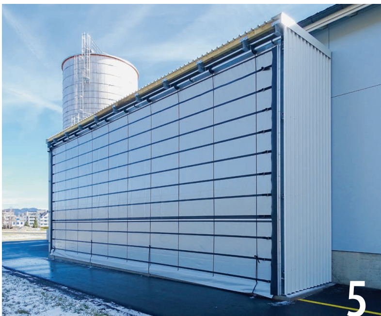
4 + 5 Kragarmregal IPE in feuerverzinkter Ausführung für den Aussenbereich, inkl. Dacheindeckung nach hinten abfallend und 2 Seitenwänden. Sonderlösung mit frontseitigem Rolltorabschluss für kompletten Wetterschutz.
