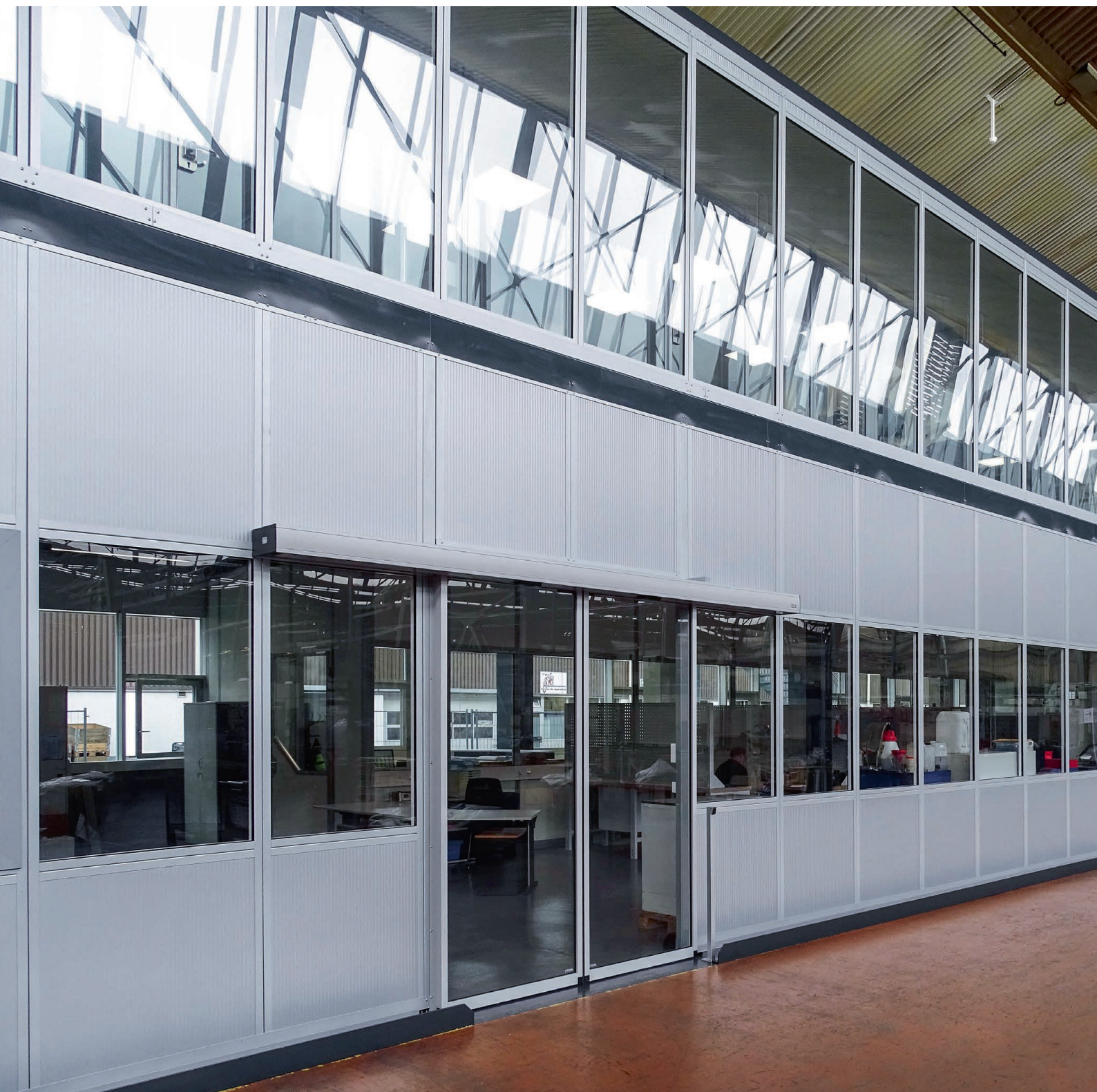
1 – 3 Raumtrennwand K60, 2-geschossig, mit integrierter Lagerbühne. Unten Serviceabteilung mit integrierter Kranbahn, getragen von der Lagerbühne, oben Bürobereich der Unterhaltsabteilung. Grosszügige Glasfronten, dadurch helle Räume und gute Übersicht.
