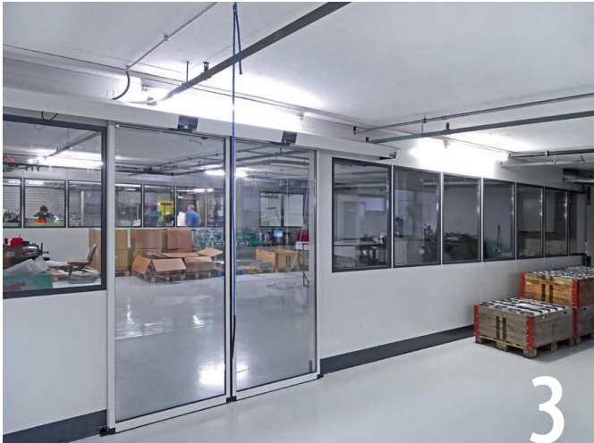
1 – 5 Trennwandsystem G45 in Kombination mit elektrischen Glas-Schiebetüren in 1- oder mehrflügeliger Ausführung
