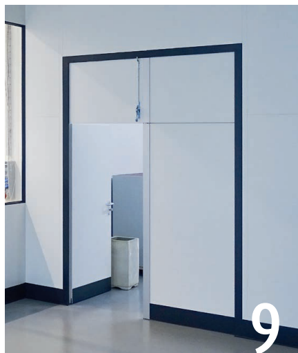
4-flügelite Türe, basierend auf der Doppelflügeltüre mit Stand- und Gehflügel, ohne Glasausschnitt, mit 2 zusätzlichen oberen Flügeln zum Ein- und Ausbringen von Maschinen
