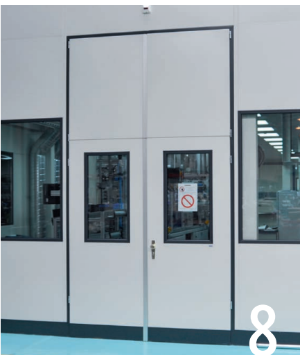
4-flügelige Türe, basierend auf der Doppelflügeltüre mit Stand- und Gehflügel, inkl. Glasausschnitt mit 2 zusätzlichen oberen Flügeln zum Ein- und Ausbringen von Maschinen
