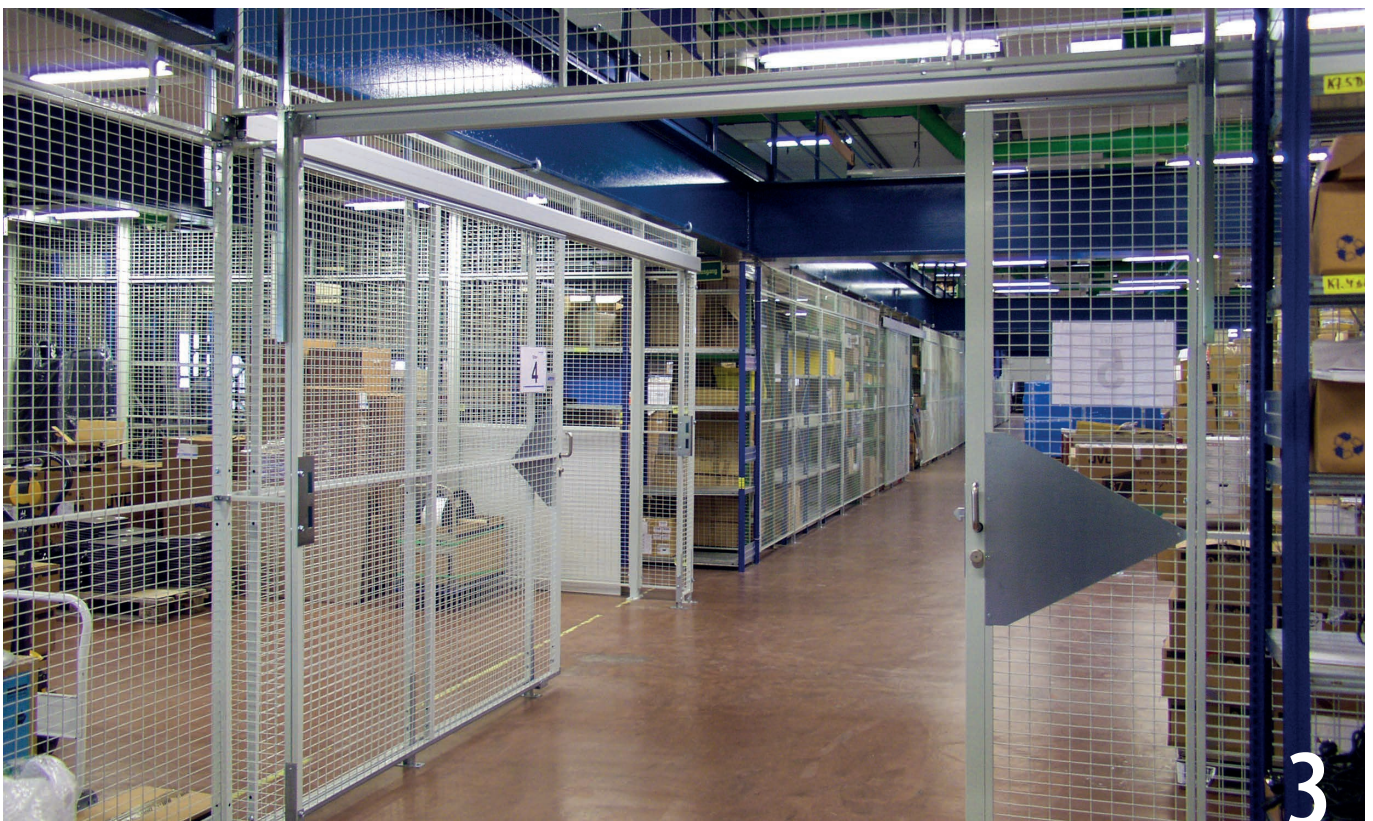
1-3 Abtrennung von Lagerräumen. Gittertrennwände KS mit Schiebetüren
