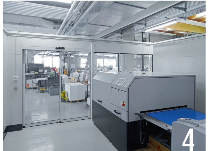
1 – 5 Trennwandsystem G45 in Kombination mit elektrischen Glas-Schiebetüren in 1- oder mehrflügeliger Ausführung
